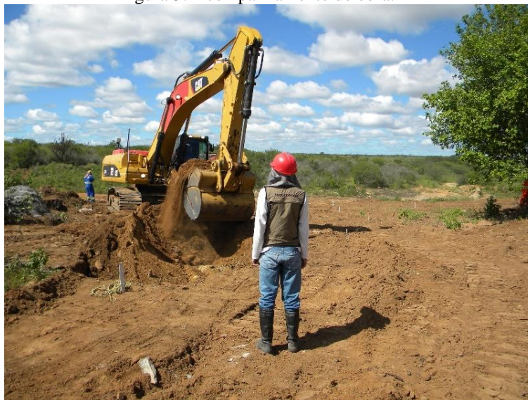
Figura 5: Acompanhamento de obra.
