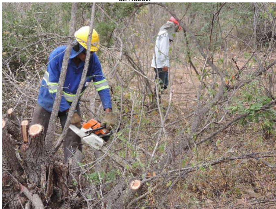
Figura 10: Acompanhamento de obra - riscos físicos (ruídos, altas temperaturas, vibrações) presentes na atividade.
