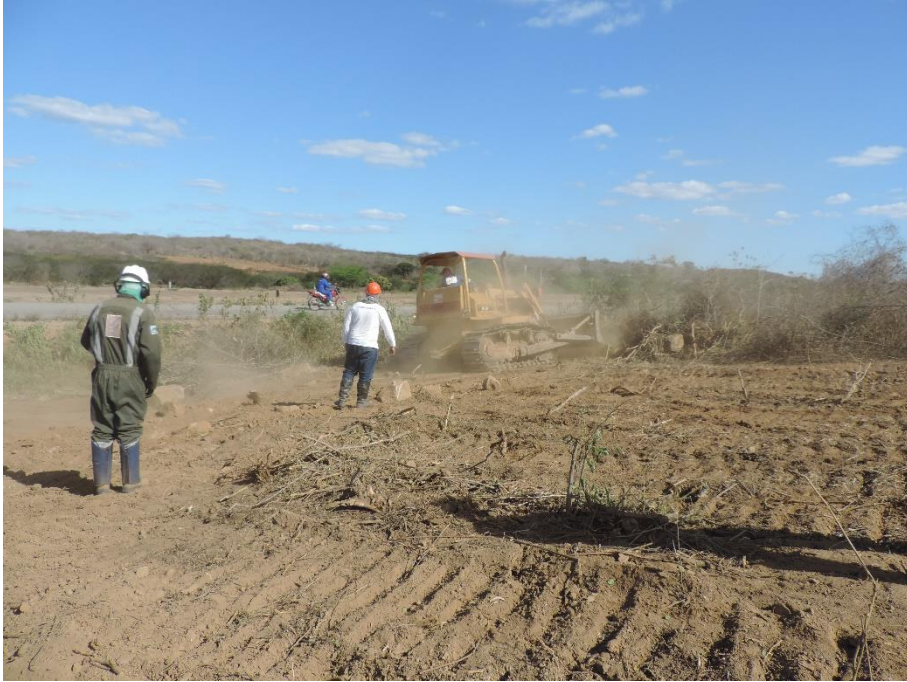
Figura 11: Acompanhamento de obra – riscos químicos (poeira).
