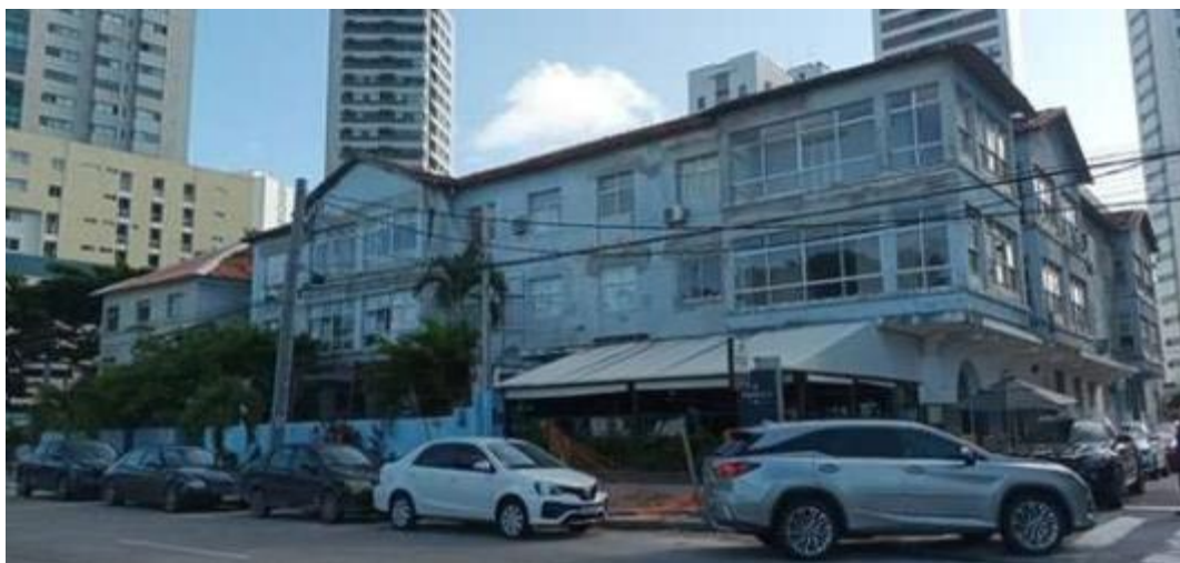
Figura 14: Edifício Oceania. Fonte: Stela Barthel, 2024.
