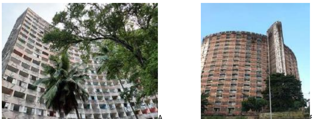
Figura 38: A. Edifício Holiday, fachadas frontais; e B. posterior. Fonte: Stela Barthel, 2024.
