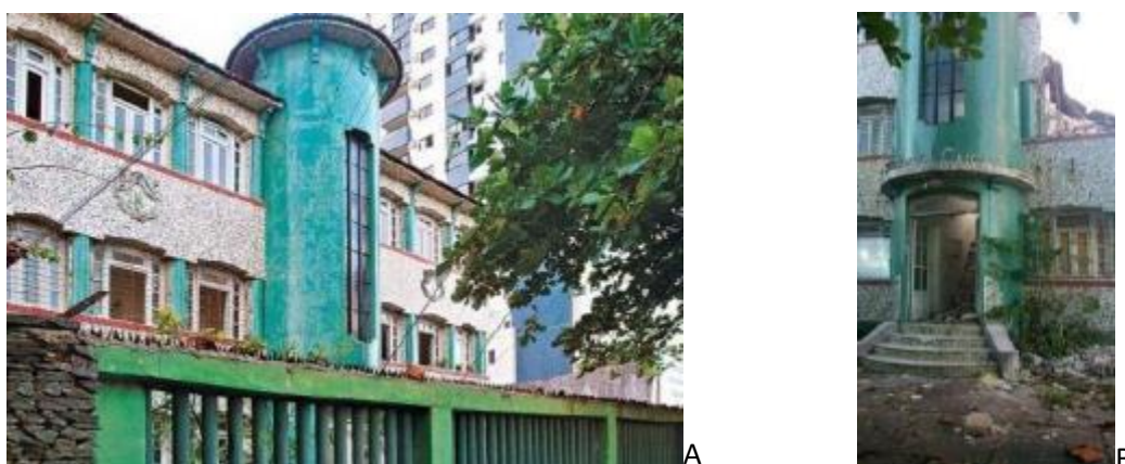
Figura 12: A. Edifício Caiçara. Fonte: Guione, 2016; B. Demolição. Fonte: Stela Barthel, 2024.
