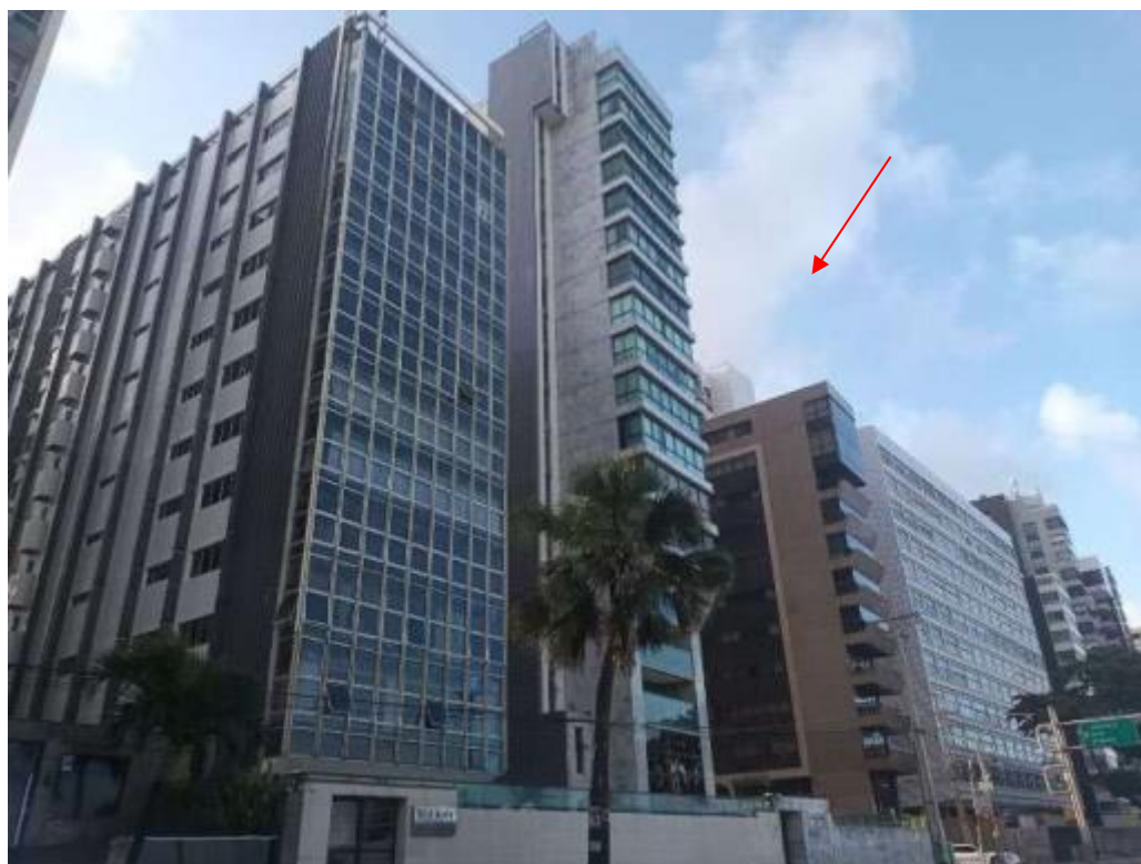
Figura 40: Edif. Acaiaca na Avenida Boa Viagem. Fonte: S. Barthel, 2024.
