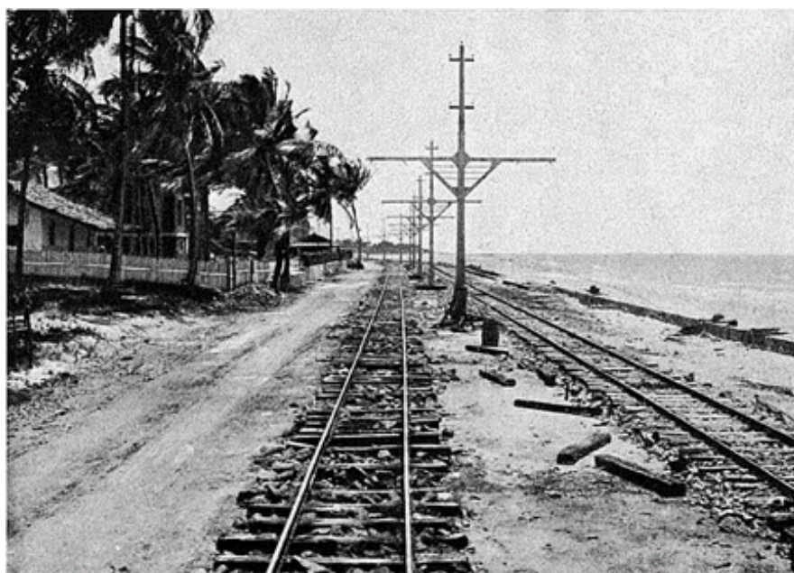
Figura 3: Obras na antiga Avenida Beira-mar. Fonte: www.plubambo.blogspot.com , s/d.
