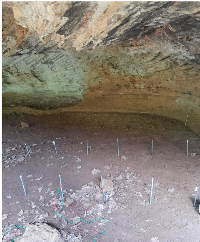
Figura 3: Área geral do sítio TPA, detalhes do intemperismo alveolar nas paredes do abrigo. Fonte: Acervo do Laboratório de Preservação Patrimonial (2024).
