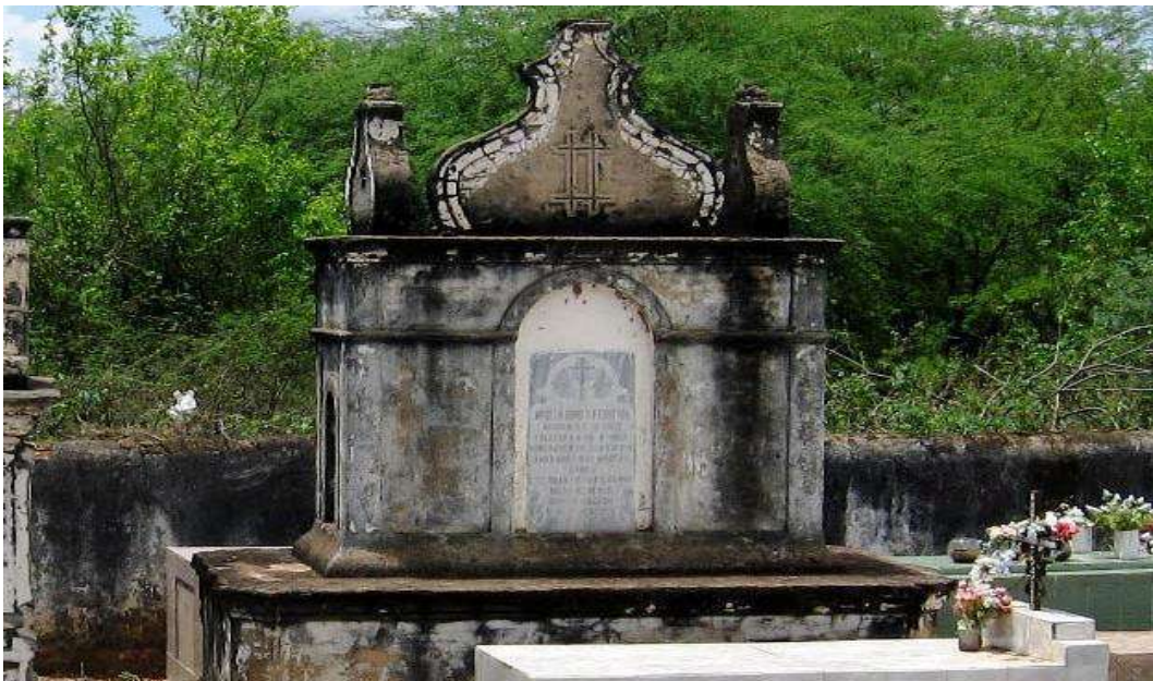
Figura 15: Mausoléu com 4m de altura. Este se diferencia dos demais jazigos por estar com sua orientação voltada para o Norte.
