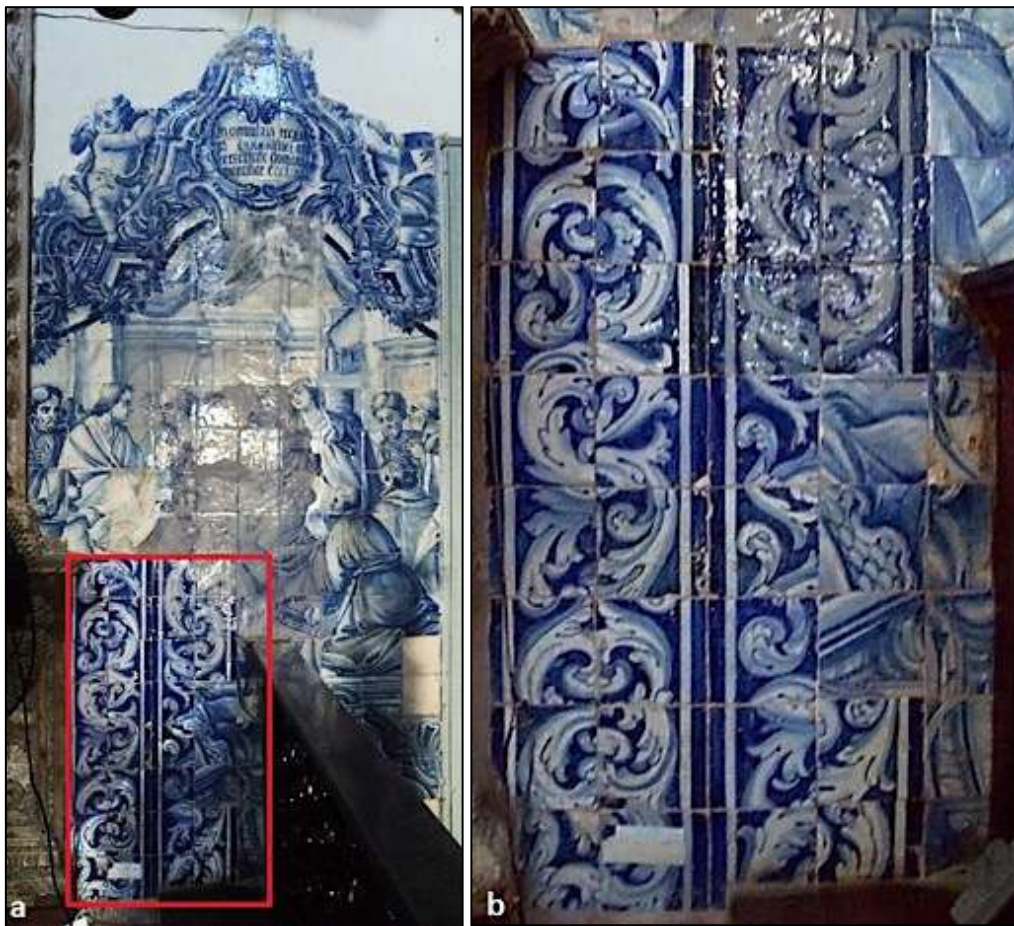
Figura 20: Painel representando a morte de Nossa Senhora (a) e detalhe das peças diferentes das primitivas (b), Igreja de Nossa Senhora das Neves do Convento Franciscano de Olinda, século XVIII. Foto: Jaqueline Silva, 2014.
