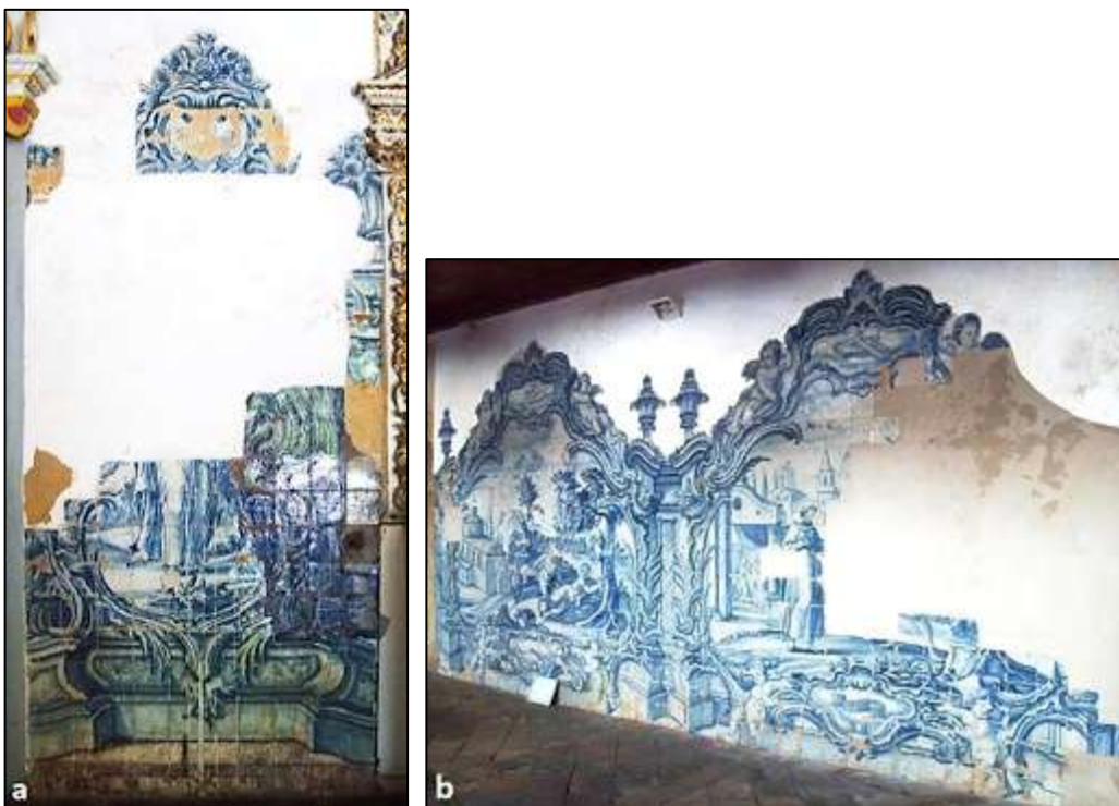
Figura 27: Painéis apresentando desprendimento do biscoito e preenchimento das lacunas com argamassa, Capela de Santa Ana (a) e claustro (b) do Convento Franciscano de Olinda, século XVIII. Foto: Jaqueline Silva, 2014.
