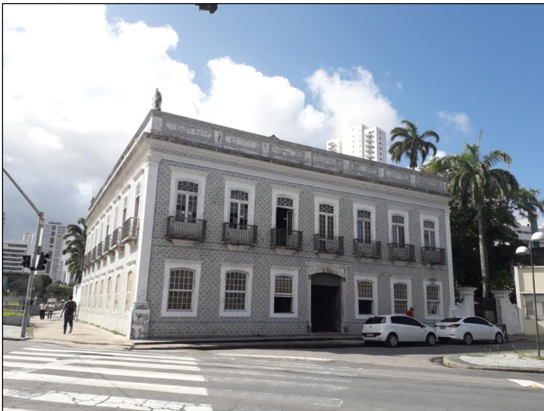
Figura 1: Casa-grande do engenho da Madalena. Foto: Hilayane Maras, 2019.
