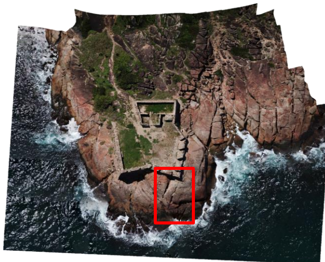
Figura 11: Ortofoto da área sobrevoada com VANT referente ao Forte Castelo do Mar, com detalhe em uma área escolhida que abrange parte da muralha e o piso. Fonte: GEAGT-UFPE, 2019.
