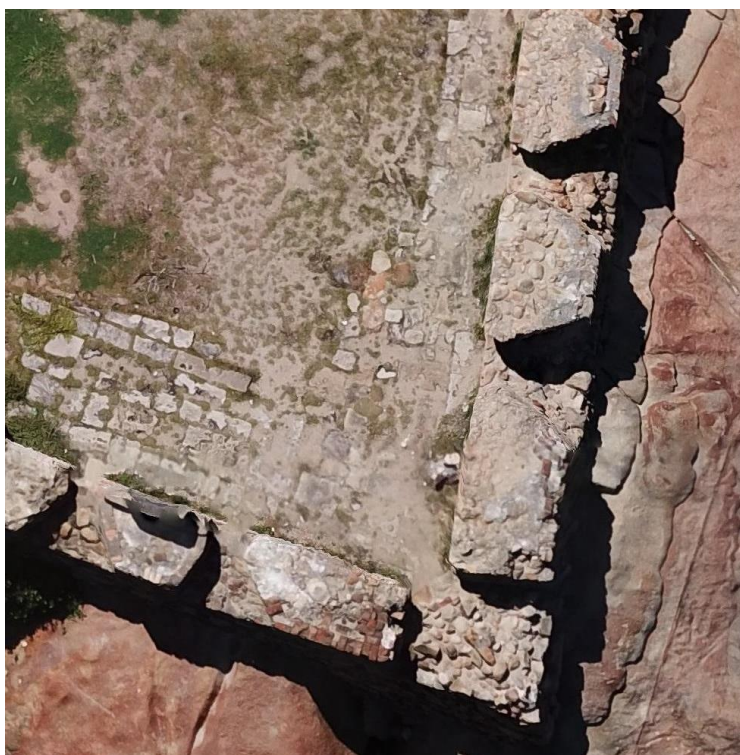
Figura 12: Detalhe da área destacada na figura 11, exibindo o piso em parte do pátio. Fonte: GEAGT-UFPE, 2019.
