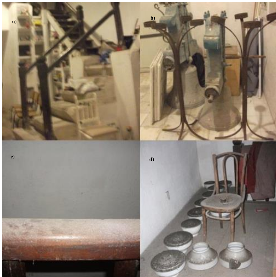
Figura 12: Espaços constituintes da igreja que estão em descaso. (a) Área dos jazigos em meio ao descaso e bagunça; (b) sinos e outros elementos históricos da igreja em abandono pelos corredores; (c) acúmulo excessivo de poeira nas escadarias; (d) acúmulo de poeira, descaso e abandono dos artefatos históricos pelos cômodos da igreja. Fonte: Acervo pessoal, 2018.
