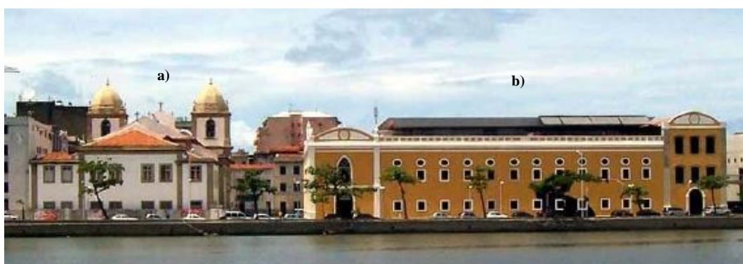
Figura 03: Fachadas posteriores (a) Igreja da Madre de Deus; (b) Convento, hoje Shopping Paço Alfândega. Fonte: Acervo pessoal, 2013.
