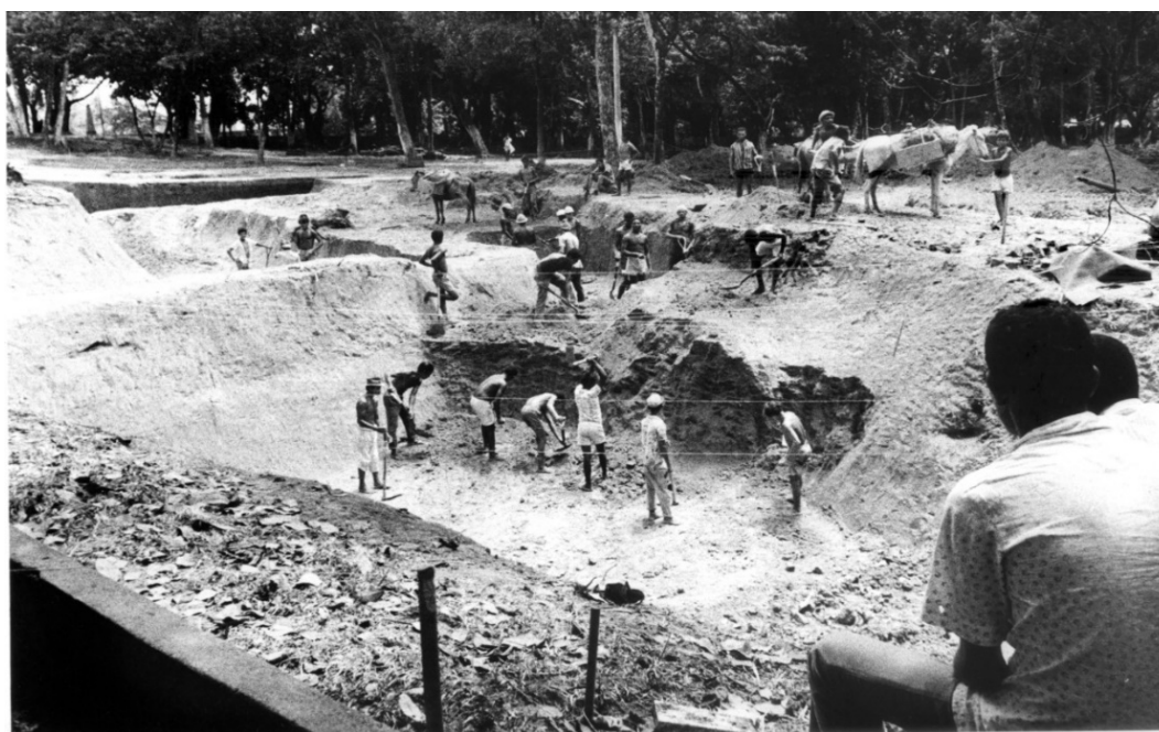
Figura 2: Trabalhos de desobstrução do entulho do fosso do Forte Real do Bom Jesus, conforme notícia veiculada em jornais da época. Fonte: Jornal Universitário – Recife-PE – Setembro, 1972.
