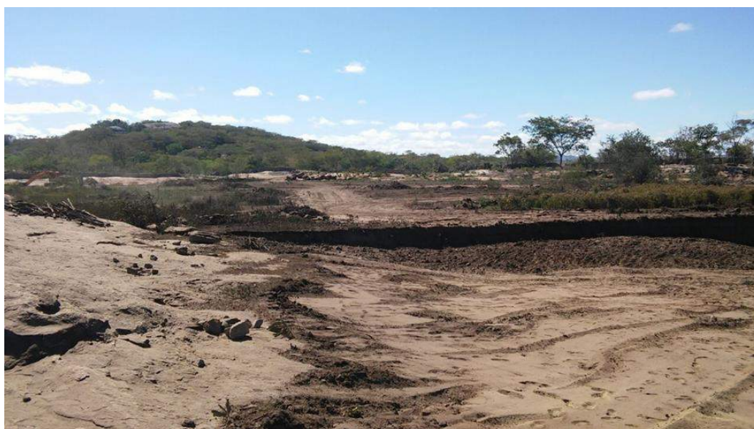
Figura 3: Detalhe do sítio Peri-Peri, Alagoinha – PE/BR, onde é possível ver marcas de pneus das máquinas utilizadas na obra. Acervo: Alexandre Bittencourt L. Marques. Foto disseminada pelos alunos nas redes sociais, 2016.
