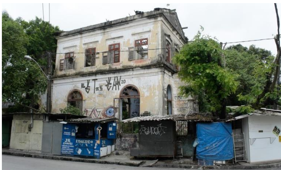
Figura 7: Lateral direita do casarão da Várzea. Fonte: Alexandre Filho, 2019.
