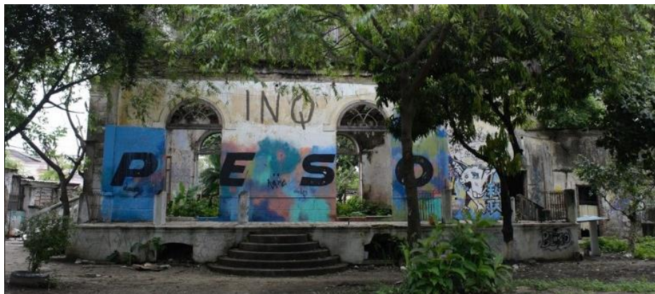
Figura 8: Lateral direita do casarão da Várzea. Fonte: Alexandre Filho, 2019.
